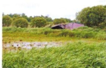
Le gabion sud
