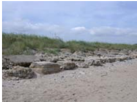
Photo 1: enrochement intégré en pente douce et revégétalisation du cordon
