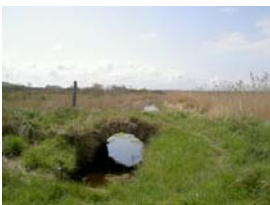
Photo 4 : réseau de fossés du marais de Ver-sur-Mer (crédit ; SMCL)
