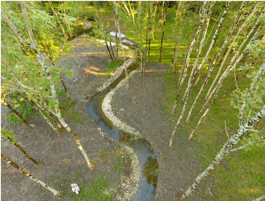
Figure 1. Restauration incluant deux types d'opération : reméandrage et reconstitution du matelas alluvial. Le Taillon à St Ciers du Taillon (17).
