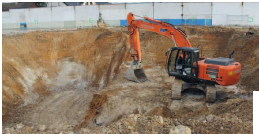
**Des prélèvements sont effectués dans des trous de six mètres de profondeur.**
