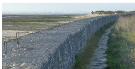
Gabions sur la digue de la Loge du Guet à Ars-en-Ré (17) (source : www.notre-ile-de-re.com )
