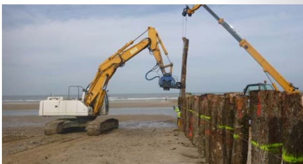
Chantier de Sangatte : mise en œuvre des enrochements sur la digue (en haut) et implantation des pieux (en bas) (source : DDTM 62)
