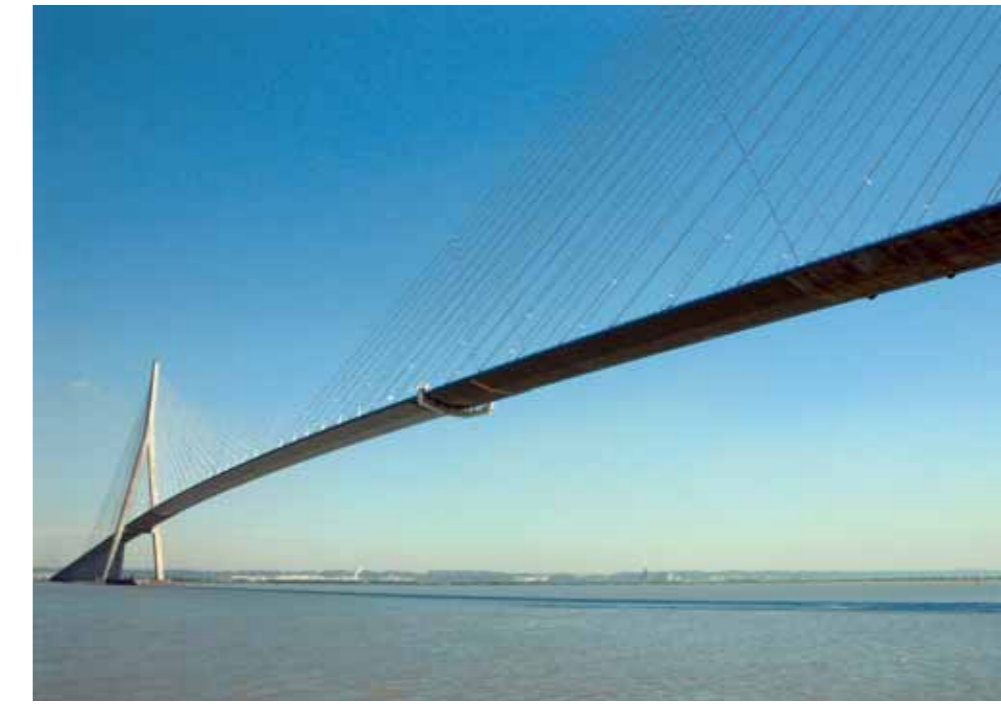
Pont de Normandie
