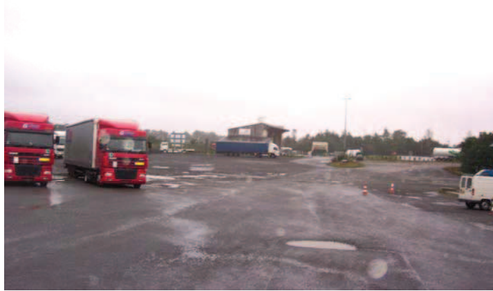
Figure 4 Parking de l'aire de Guilberville
