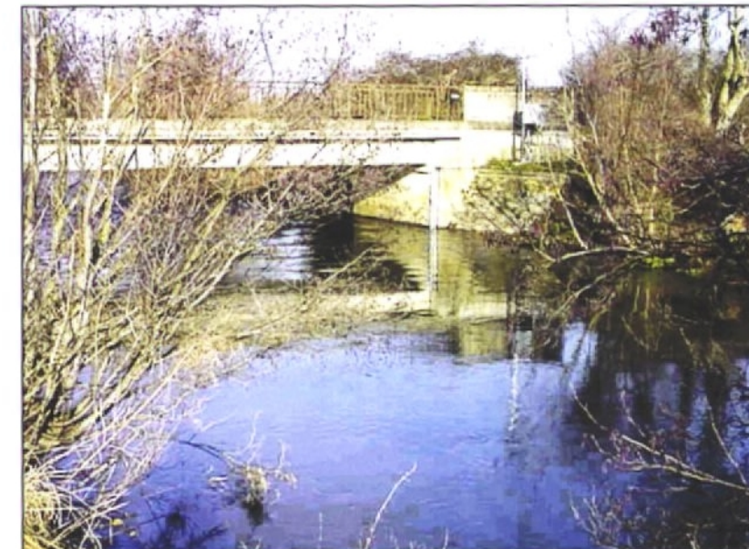
Station hydrométrique sur la Dives
