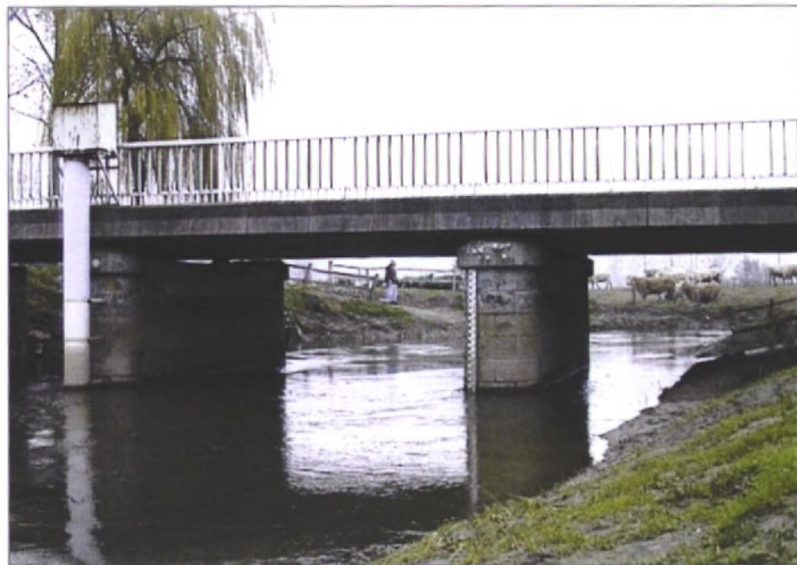
Station hydrométrique sur la Sée
