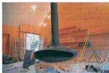
Cette étrange bouche de fer est la cheminée de la nouvelle « salle de convivialité » de la Maison du Parc. Du bois de pommiers et de poiriers a été utilisé pour les murs et le mobilier. « Le public rentrera par cet espace où sera installée une bibliothèque. Toutes les missions du Parc naturel y seront présentées », explique Mélanie Massias.
