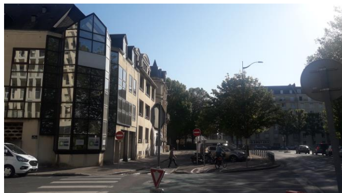
Figure 21 : nouveau bureau de la réserve naturelle dans les locaux du Département du Calvados à Caen
