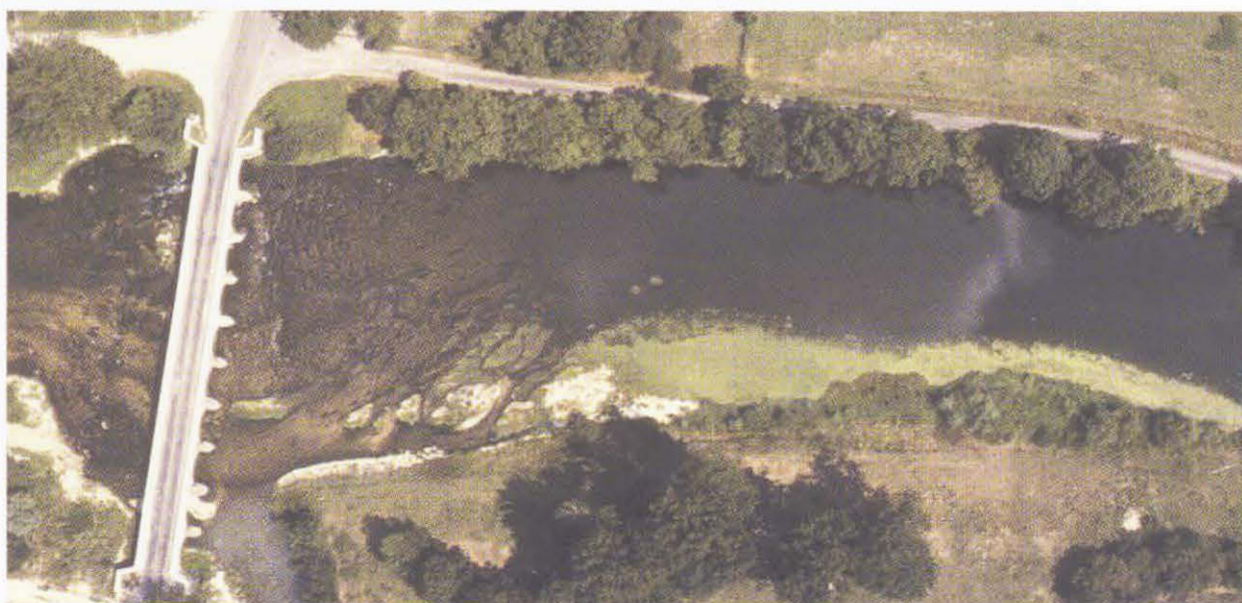
Figure 16 : Exemple de photographie aérienne montrant le recouvrement de la rivière par les macrophytes dans un secteur élargi, à proximité d'un pont.
