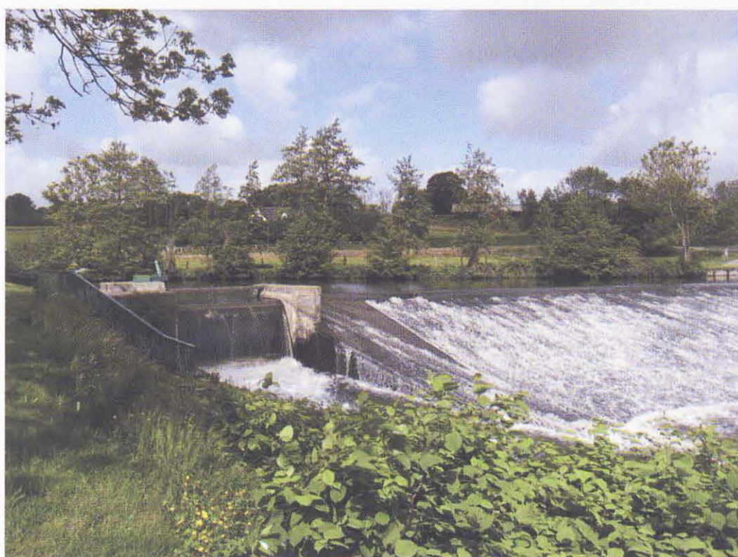
Figure 20 : Les Claies de Vire, seuil éclusé le plus en aval sur la Vire. Aujourd'hui, l'aménagement de passes à poissons permet l'observation de la remontée des poissons migrateurs amphihalins*.
