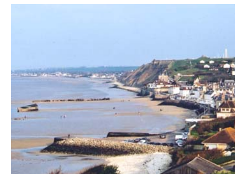
Urbanisation, falaise et caissons vues de la petite route de la falaise ouest
