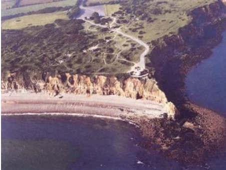
Vue aérienne générale
