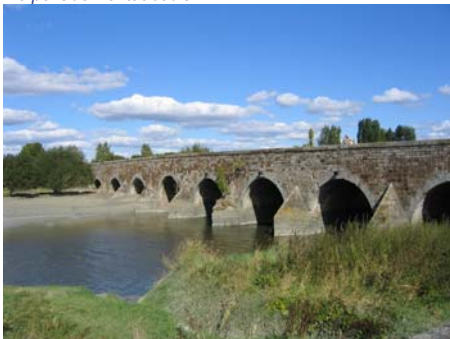
Le pont de Pontaubault
