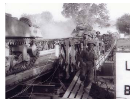
Le premier pont Bailey le London Bridge - 1944
