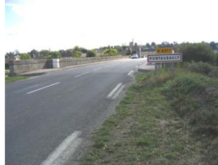
La route départementale à son arrivée sur le pont
