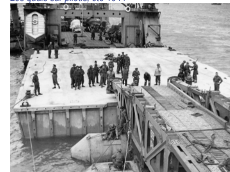
Les quais sur pilotis, été 1944
