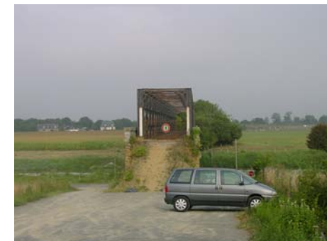
L'ancienne voie de chemin de fer
