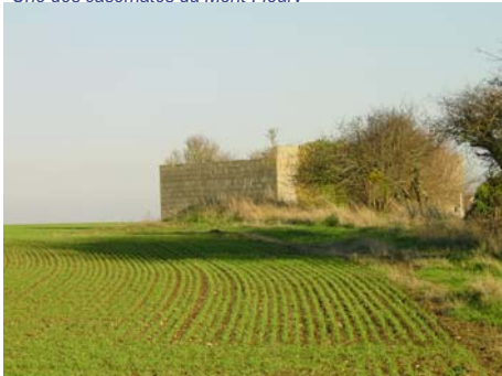
Une des casemates du Mont-Fleury
