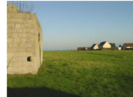
Nouveau lotissement en covisibilité avec une des casemates
