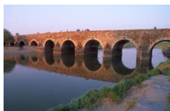
PONT DE PONTAUBAULT
