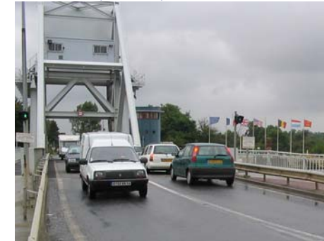
Des mats à drapeaux mal placés.
