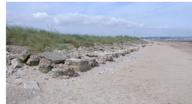
3 Traitement d'un secteur de la digue existant satisfaisant et pérenne.
