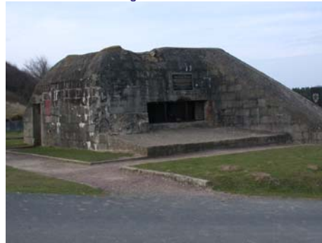
Cheminement le long d'un blockhaus
