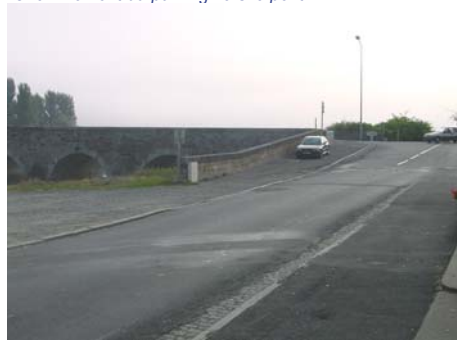
Cheminement du parking vers le pont
