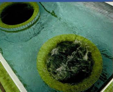
Arrivée et départ d'eau au réservoir de Montsouris à Paris.
