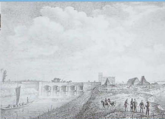
Travaux au pont du petit Vey
