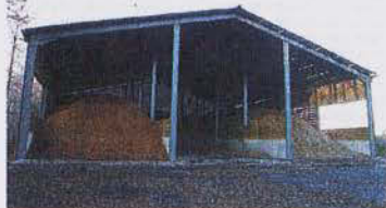
Ici un exemple de plateforme de stockage de bois avec hangar.
