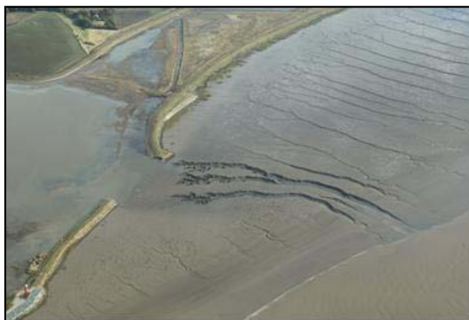
18. La brèche artificielle créée dans la digue de Paull Holmes Strays, dans l'estuaire du Humber (GB) (Environment Agency for England and Wales)
