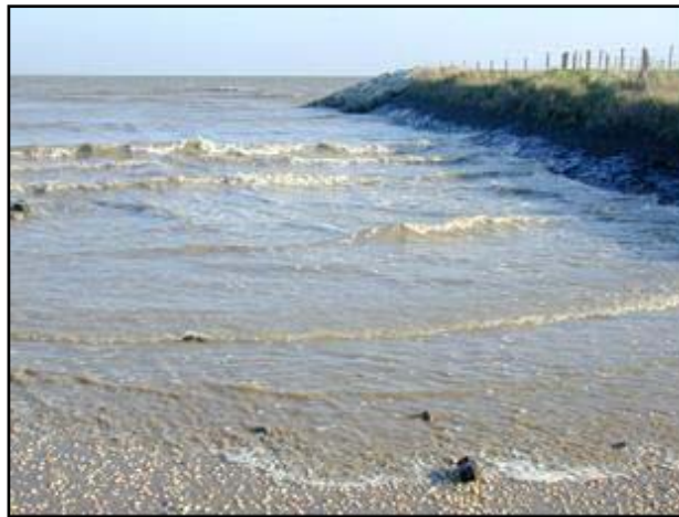
10. Etude de l'état des digues du polder du Rouff dans la baie des Veys, Manche (cl. F. Verger)
