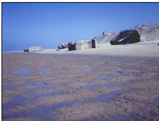
3. Une mise en évidence de l'érosion : des blockhaus basculés sur l'estran au Cap-Ferret, Gironde (cl. R. Paskoff)
