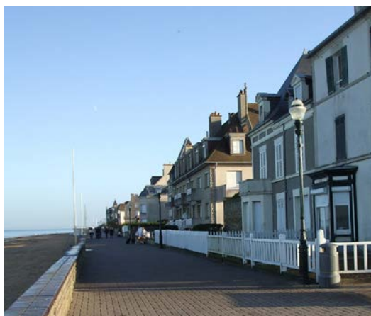
Copropriété de bord de mer à Saint-Aubin-sur-mer
