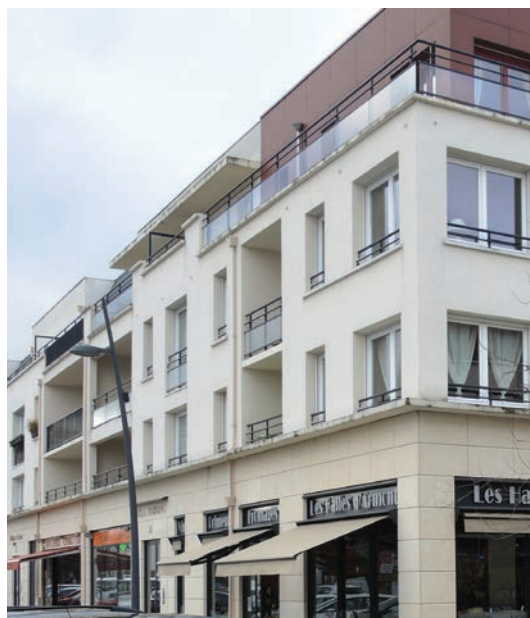
Copropriété avec commerces en rez-de-chaussée à Mondeville
