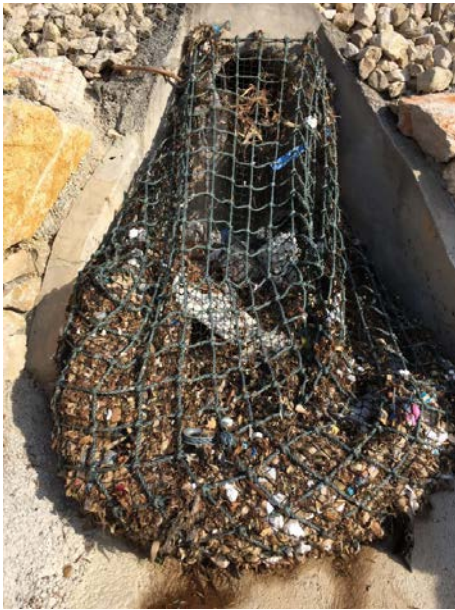
Illustration 22 : Filets sur exutoires (Crédit : Stormwatersystems)
