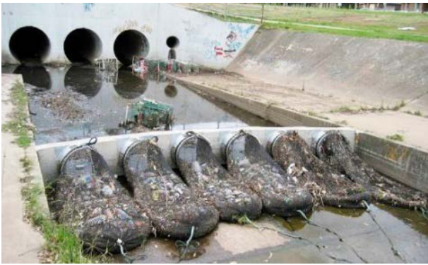
Illustration 22 : Filets sur exutoires (Crédit : Stormwatersystems)
