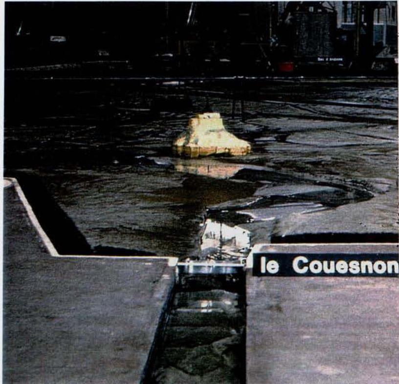
Ces résultats risquaient malheureusement d'être temporaires et progressivement le Couesnon s'ensablait perdant une partie de sa puissance hydraulique, comme cela avait d'ailleurs été constaté avant la réalisation du barrage de la Caserne.
