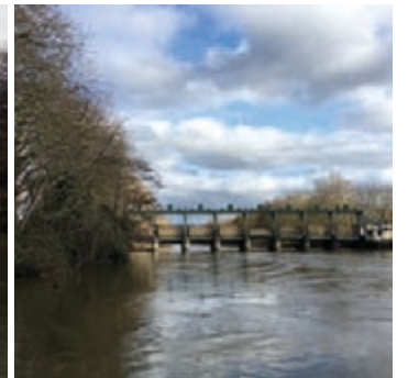
Écluse de Montalivet
