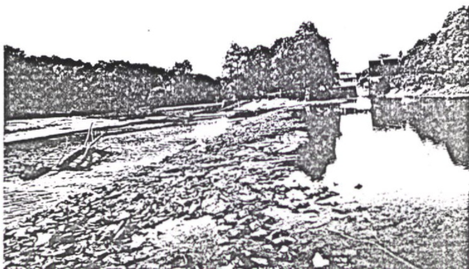
... ou vide. L' an- -cien chenal de l'Orne devient visible. On re- -marque la pente très douce entre la berge actuelle et le chenal. Contre le déversoir, début d'accumulation de sédiments.
