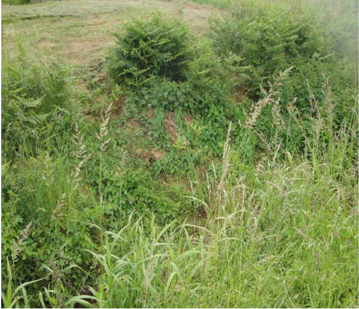
Cours d'eau calibré
