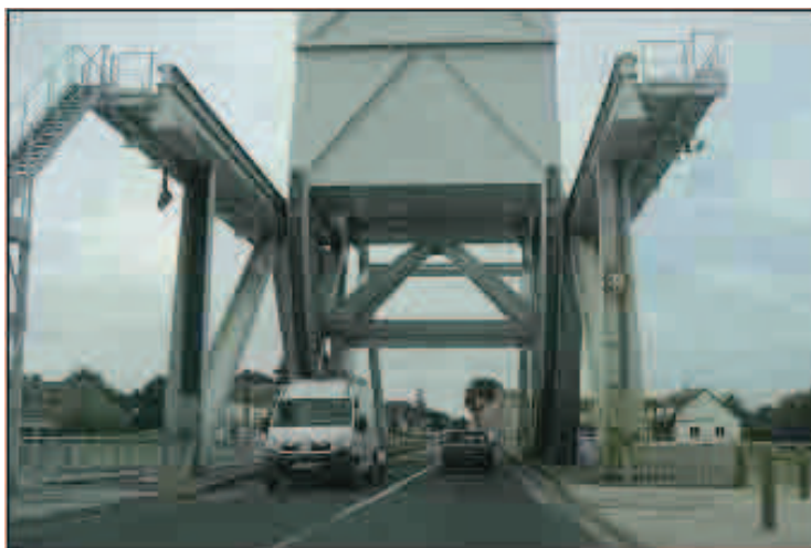
Le pont de Bénouville : une traversée des piétons protégée mais inconfortable
