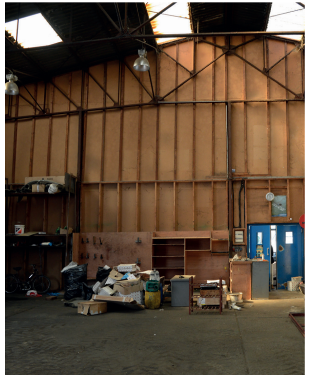
Bretteville sur Laize : la transformation d'une halle agricole en lieu commun.
