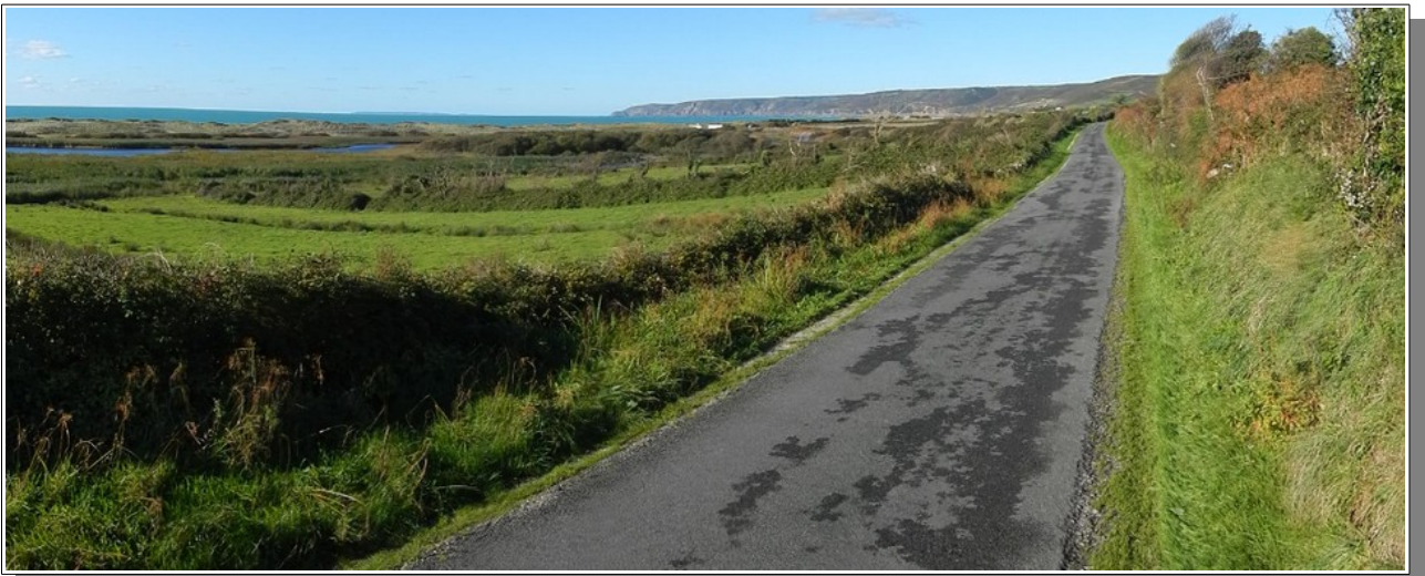
Vue du secteur 10 à 8. À gauche un mur de pierres sèches plus ou moins perméable en fonction de son état de dégradation.
