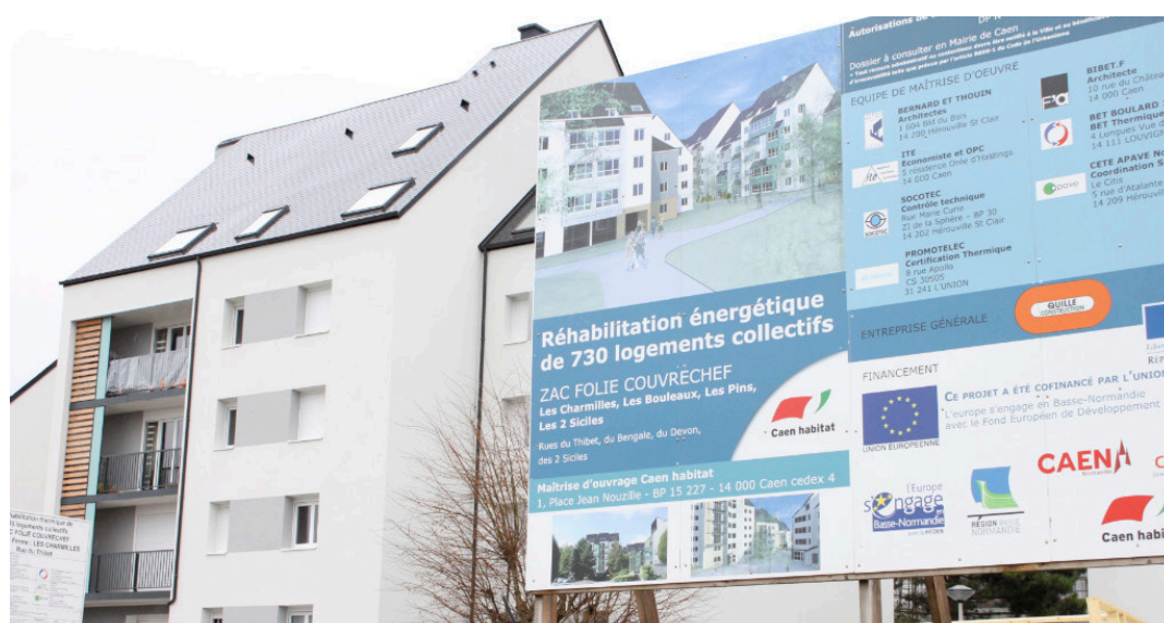
Réhabilitation énergétique à la ZAC de la Folie Couvrechef
