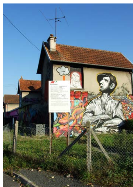
Maison ouvrière du Clos Joli peu avant démolition, quartier Saint-Jean-Eudes
