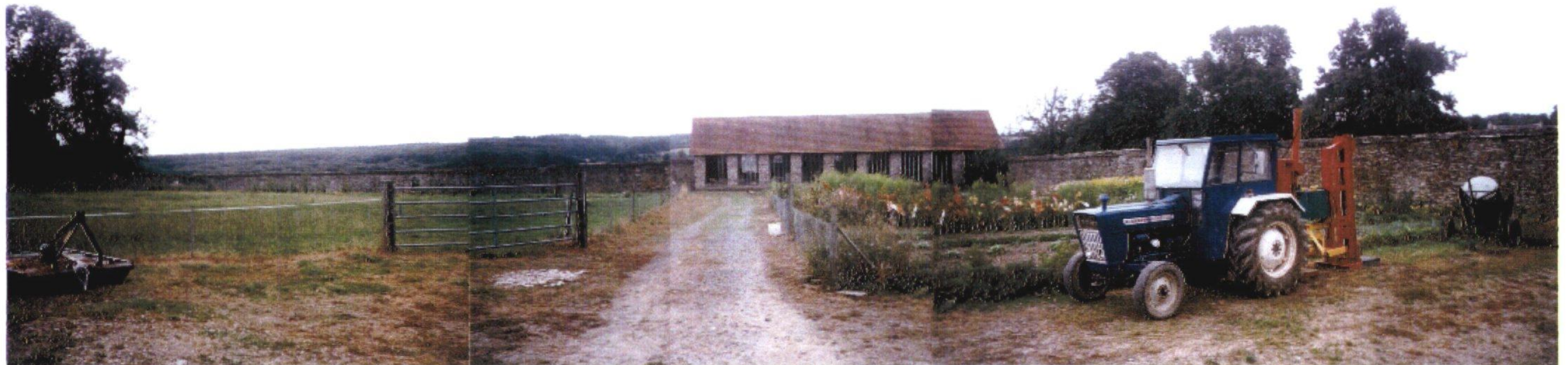
8. Le deuxième enclos du potager. Cet espace est laissé à l'abandon, les murs sont très endommagés.
