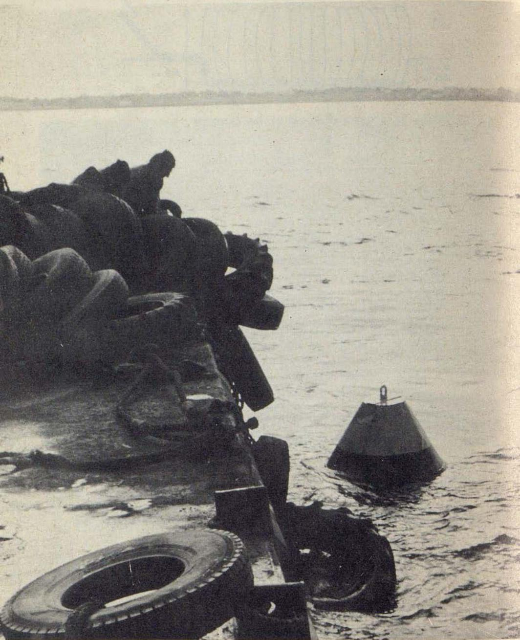
risques de dislocation sont quasiment nuls en raison de la taille et du poids de la chaîne d'amarrage. Si le récif venait à se déformer, il faudrait rigidifier l'ensemble au moyen de filins. L'opération bien qu'un peu délicate est parfaitement réalisable par des plongeurs amateurs.
