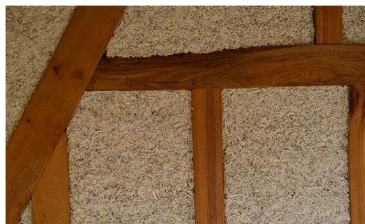
6 Béton de chanvre dans un colombage
