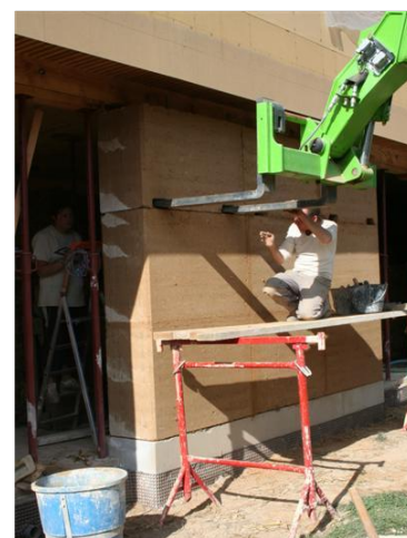
70 Mise en place d'un bloc de pisé préfabriqué, source F. Streiff
