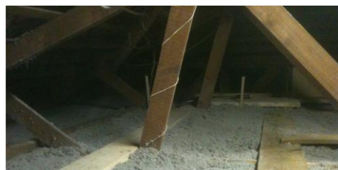
95 Combles isolés par flocage en ouate de cellulose - crédit photo
