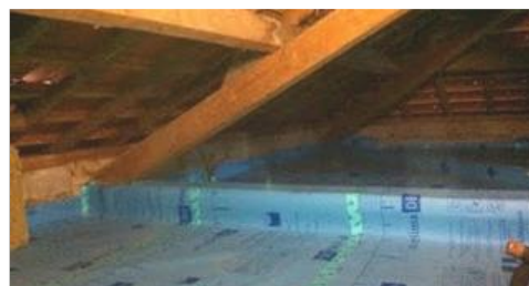
Mise en place d'un frein vapeur pour assurer l'étanchéité à l'air du bâtiment, et abaisser la pression de vapeur intérieure avant que celle-ci ne traverse l'isolant.
