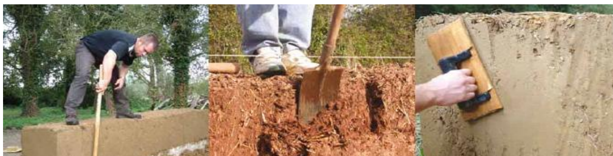
62 Compactage au bâton
