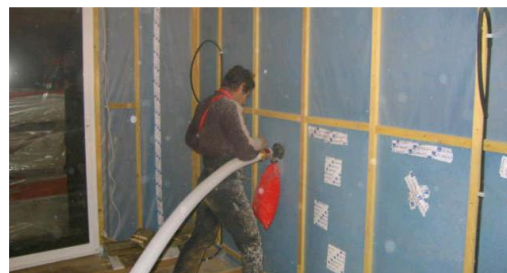
29 Insufflation de ouate de cellulose- crédit photo www.construction-naturelle.com
