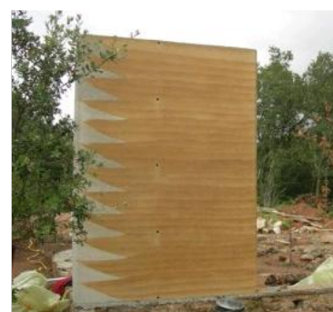
69 Mur en pisé stabilisé – crédit photo www.asterre.org
