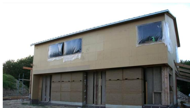
72 Murs en pisé préfabriqués, source F. Streiff
