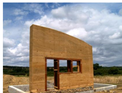
67 Mur en pisé levé – crédit photo http://storage.canalblog.com
