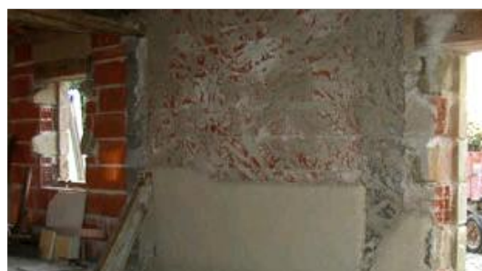
91 Crédit photo Rénovation énergétique d'un bâtiment ancien grâce à l'application d'un enduit chaux-chanvre - www.isolation-chanvre-vendee.com
