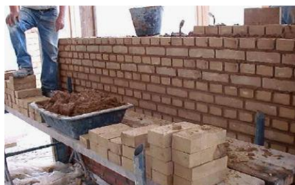
75 Montage d'un mur en briques de terre crue – crédit photo www.cd2e.com
