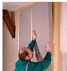
32 Pose de panneaux de ouate de cellulose
