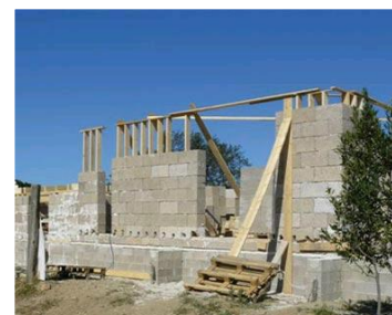
8 Construction en blocs de chanvre – Source www.batiproduit.com
