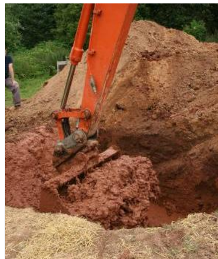
61 Préparation de la bauge à la pelleteuse
