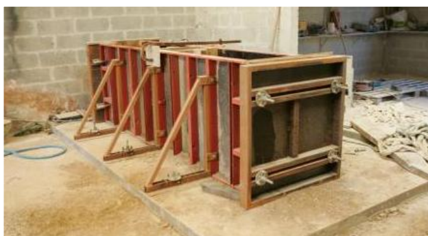
71 Coffrage de préfabrication, source F. Streiff
