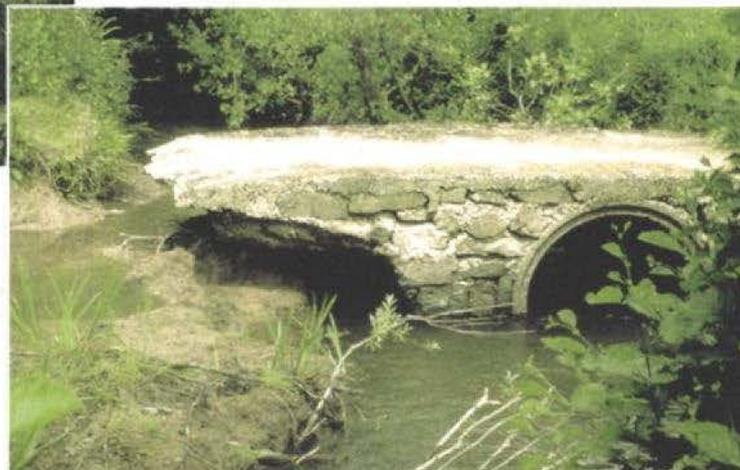
L'érosion sape l'assise d'un pont sur la Siriope
