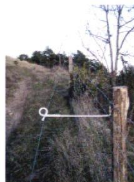
Détail des écarteurs et des tendeurs
