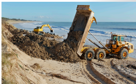
Rechargement d'un cordon dunaire
