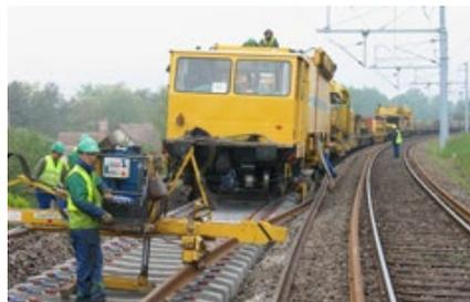
Longs Rails soudés sur traverses béton
