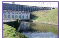
Barrage de Veziins 2
