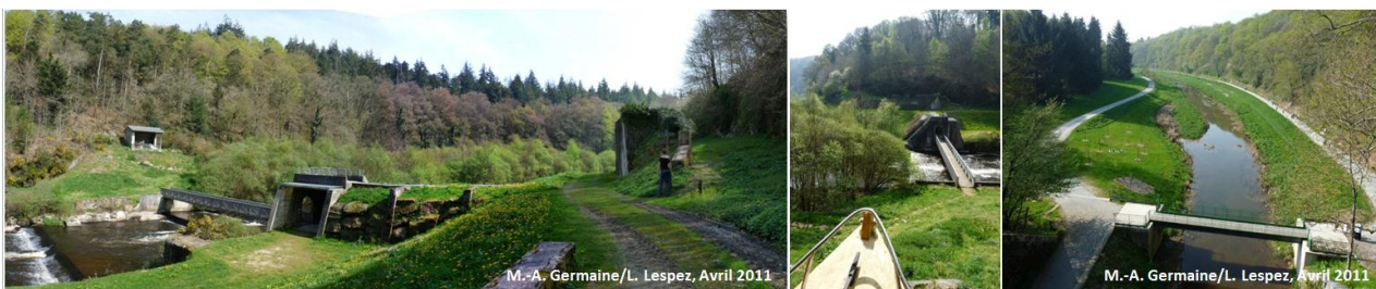
Passerelle installée à l'emplacement du barrage de Kernansquillec (Léguer, 22) ; quai et barque laissés au niveau du lac disparu (Léguer, 22) ; passerelle installée à l'emplacement du barrage du Coupeau (Vicoïn, 51).
