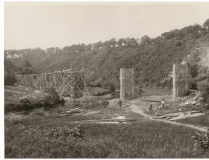
Travaux liés à la construction des barrages de la Sélune (ici la construction du pont de la République).
