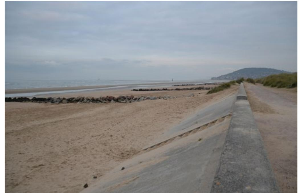
Les épis sont mis en place pour préserver la plage. Obstacles au vent et aux courants, ils réceptionnent le sable qui s'accumule sur leur flanc. Mais sans la présence de la dune, le sable s'entasse sans se répartir contre l'ouvrage maçonné.
