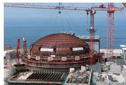
EPR en construction à Flamanville (50)
