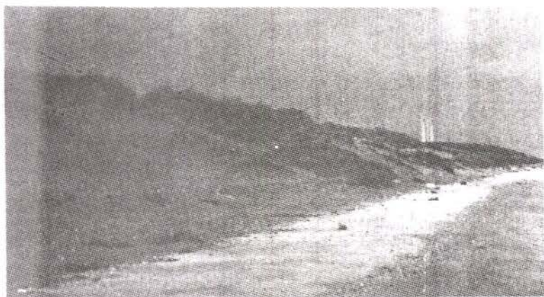
. Erosion au niveau des lotissements UTAH BEACH
