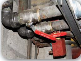
En cause, l'équipement de réglage vétuste et non optimal : vanne manuelle nécessitant une intervention.
