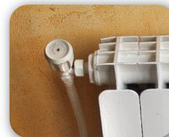
Les robinets thermostatiques permettent un ajustement de la température, en continu et si le système le permet.
