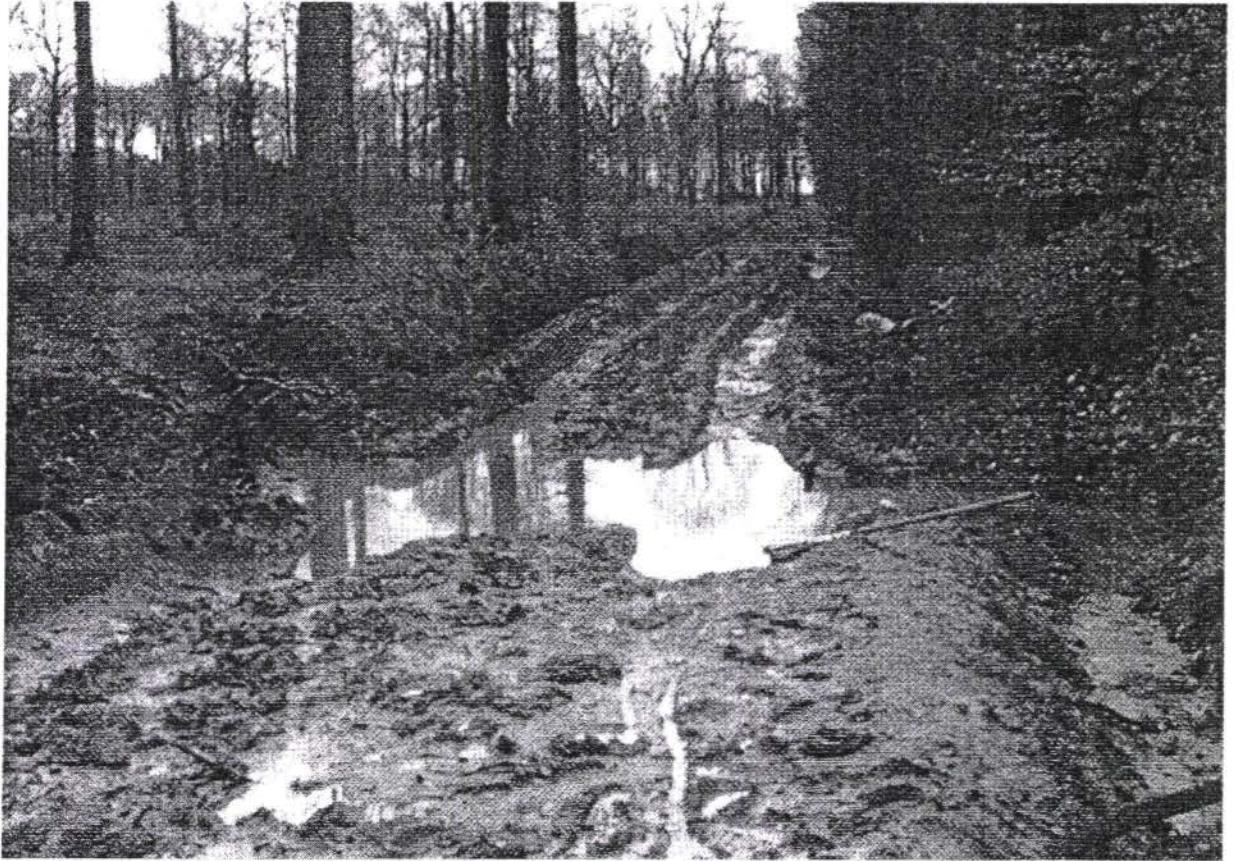
3.6.8. Ornières récentes dans la Tranchée des Etangs, non loin de la route de Bubertré
