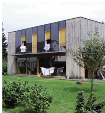
Les capteurs posés verticalement participent pleinement de la composition de la façade.
