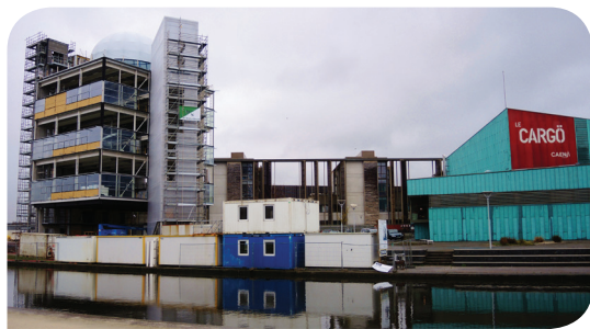
À Caen, la tête de la presqu'île est dédiée aux industries créatives avec la MRI, l'ESAM, le Cargò, le Pavillon, la Fermeture Eclair, la Bibliothèque Multimédia à Vocation Régionale.
