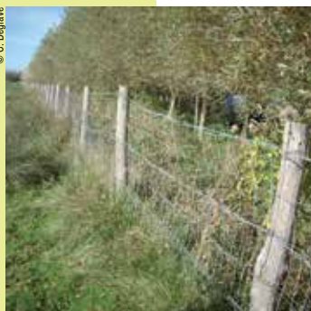
Pose de clôtures
