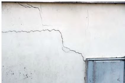
Effets d'un tassement différentiel sur une habitation
