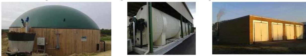
Figure : Différentes technologies de digesteur pour différents types de rations (liquide, pâteuse, solide – de gauche à droite)
