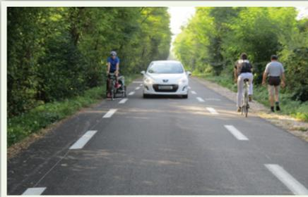
C'est une chaussée sans marquage axial, dont les lignes de rive sont rapprochées de son axe, formant ainsi une voie centrale bidirectionnelle et deux larges accotements. Elle permet une modération de la vitesse, utile pour étendre le réseau cyclable à des voiries difficilement aménageables pour les vélos.
