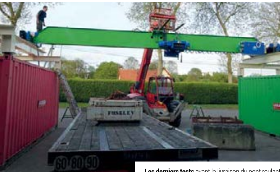
Les derniers tests avant la livraison du pont roulant.
