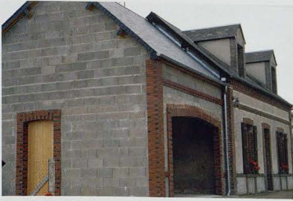
La création d'un garage dans la continuité d'une petite maison qui ne laissera pas de « cicatrice » à la fin du chantier (à proximité de Villiers-sous-Mortagne).
