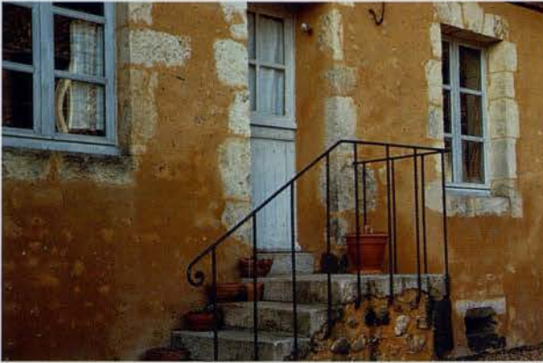
Un enduit jaune et « clouté » à base de chaux et de sable du Perche sur une maison du bourg de La Perrière.
