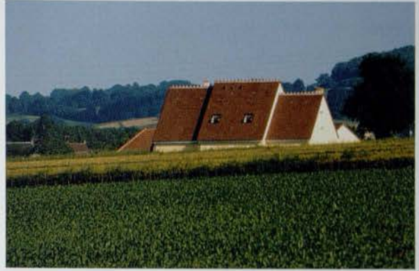
Non loin de Rémalard, une toiture aux proportions bien adaptées associant plusieurs volumes juxtaposés, une pente forte, et une couverture de tuiles plates.
