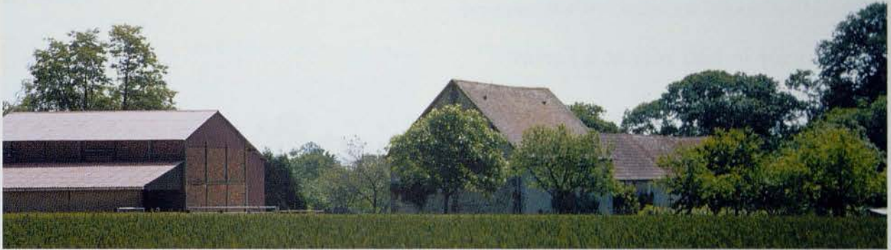
Un exemple réussi de bâtiment agricole à Parfondeval (à gauche sur la photo) : structure en béton, brique industrielle et toiture en tôle rouge accompagnent sans complexe le calcaire et la tuile plate.
