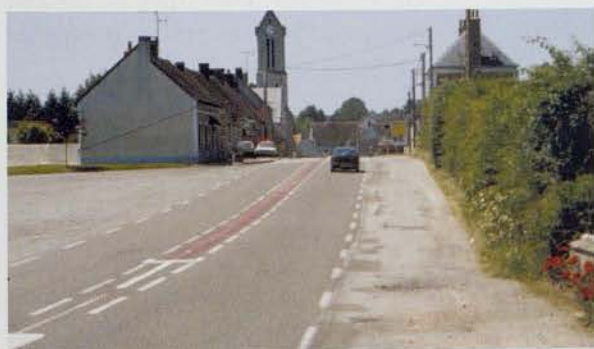
Une traversée de bourg par la D955 n'offrant pas une véritable image de rue.
