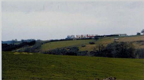
Ci-dessus, une zone d'activités implantée en rebord de plateau, dans une commune ayant une logique d'implantation en fond de vallée. Cette implantation rend les bâtiments aux couleurs vives trop visibles de loin.
