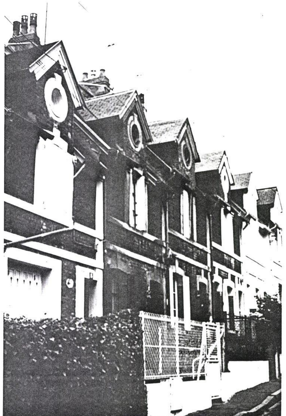
Ensemble urbain de la rue Berthier, construit en 1904 par la comtesse d'Hautpoul. Constructions d'habitations sociales
