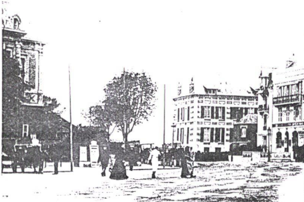
Le Chatham, au début du siècle avec ses appareillages de briques et pierres et tout son décor. Cette construction date d'avant 1845.
