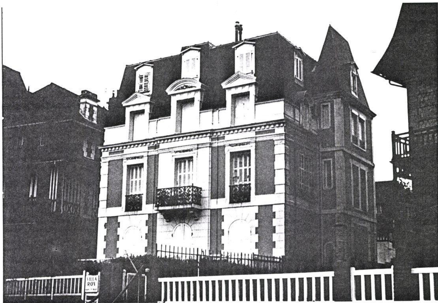
La villa Rcy, ancienne villa du baron Clary, maire de Trouville sous le Second Empire, et la villa voisine. Deux styles couramment repris dans le registre architecturale des Trouville : l'anglo-normand et le néo-Louis XIII.
