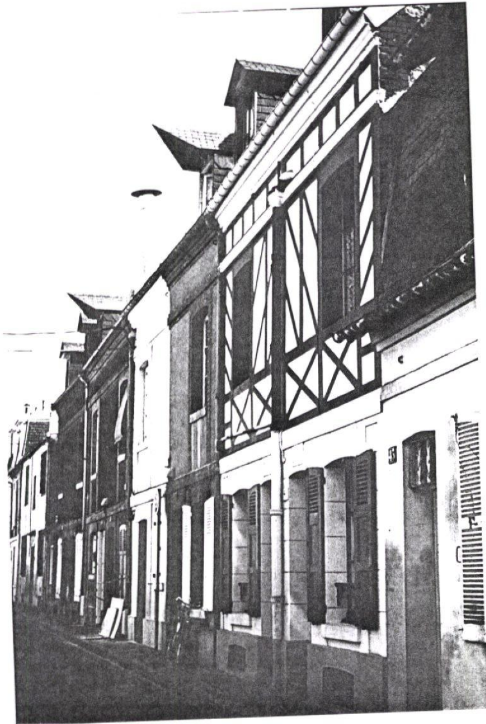
Façades donnant sur la rue des Ecores dont l'arrière donne sur le boulevard Fernand Moureaux
