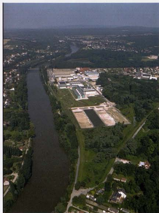
Usine d'eau potable de Méry sur Oise.
